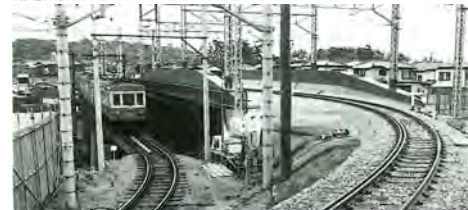
新橋梁へ切替直前の境川橋梁
