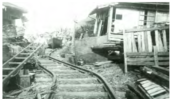
関東大震災による藤沢付近の被害 (星野写真館所蔵)
