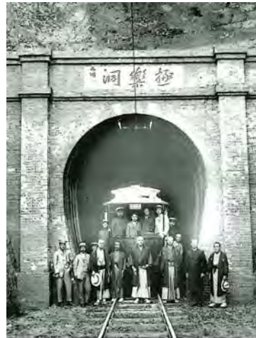
難工事のすえ開通した隧道 (福井栄一氏所蔵)
