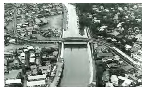
完成した境川橋梁と鵜沼駅
