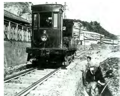
膠越一日取間における専用軌道化工事
